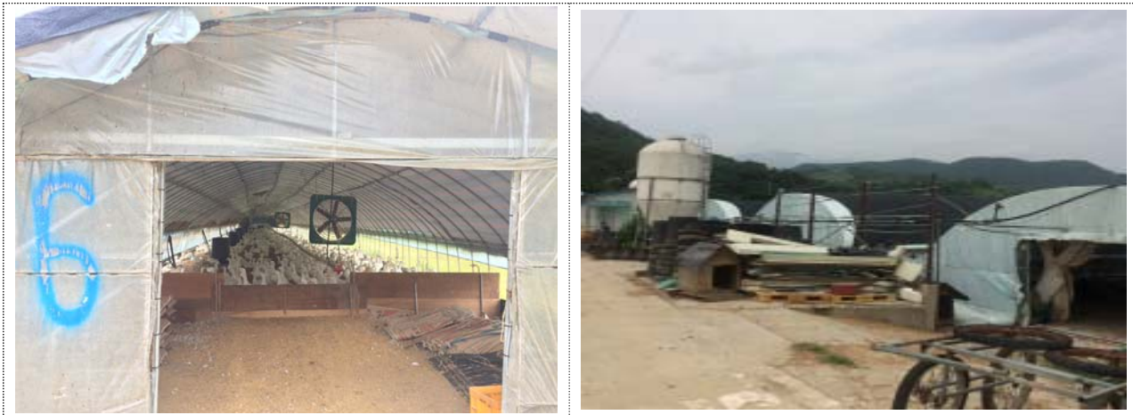
<그림 2> 낙후된 비닐하우스형 오리 축사와 축사 내 환경(원치커튼식 환기)
